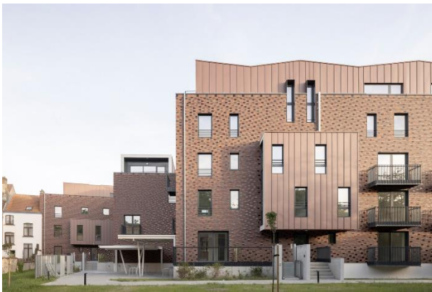
Рис. 46 Загальний вид Roche Fatale Social Housing Renovation, бюро P&P Architectes + Atelier d'Architecture A4, Бельгія [47]
