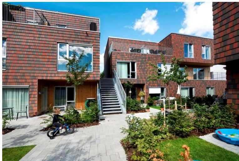
Рис. 35 Загальний вигляд AlmenBolig+, передмістя Копенгагену, Данія, 2018 [41]
