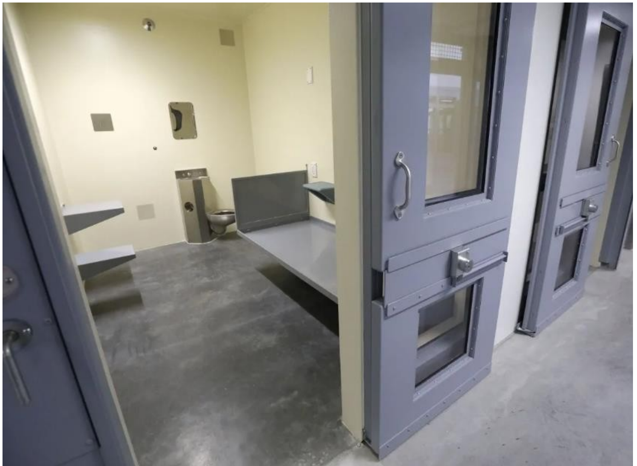
Рис. 1.7. Камера на одного у будівлі суворого режиму для чоловіків у в'язниці штату Юта. Солт-Лейк-Сімі. 2021 р. ФОТО - Крістін Мерфі, Deseret News https://www.deseret.com/utah/2021/11/18/22783406/5-things-you-need-to-know-about-the-new-utah-state-prison-when-old-one-torn-down-corrections-inmates
