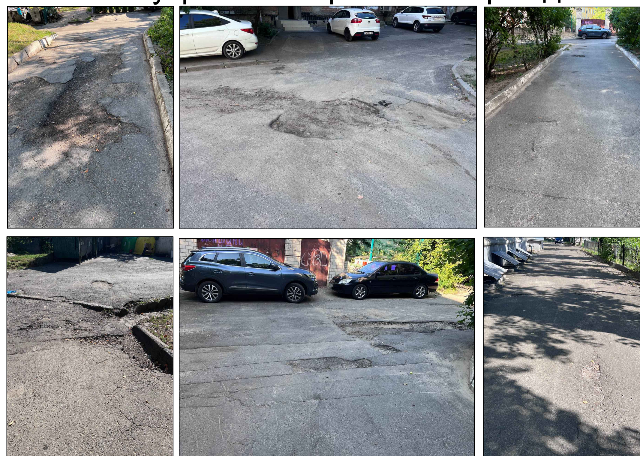
Дорожнє покриття внутрішньоквартальних проїздів
