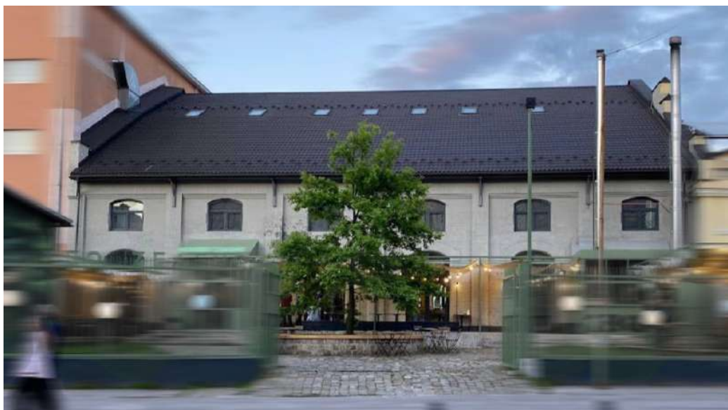
Рис.2.1.2 Фасад колишньої промислової будівлі
