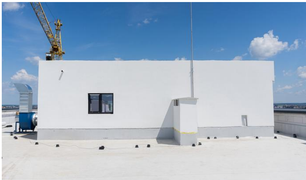
Рис 9.1. – Зовнішній вигляд дахової котельні
