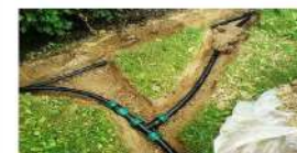
ВНУТРІШНЬОГРУНТОВА СИСТЕМА ПОЛИВУ
