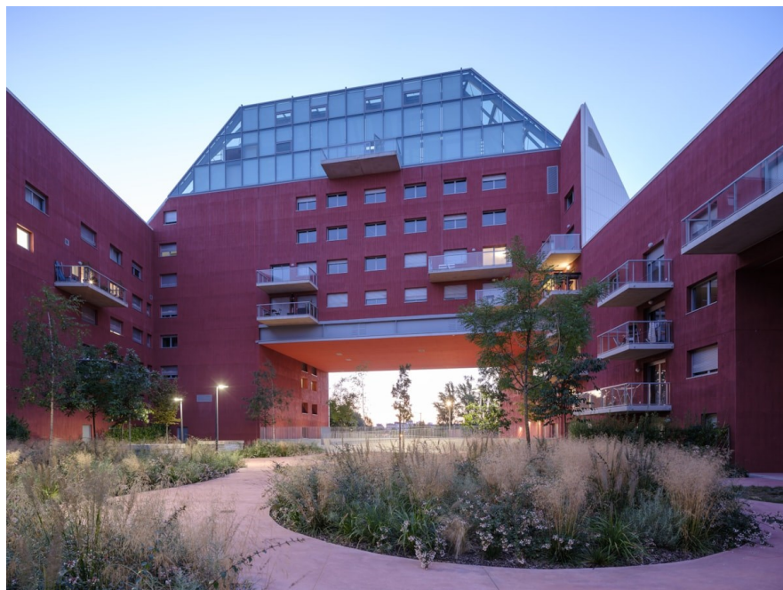
Рис. 2.1.3 Північно-східний фасад з внутрішнього двору
