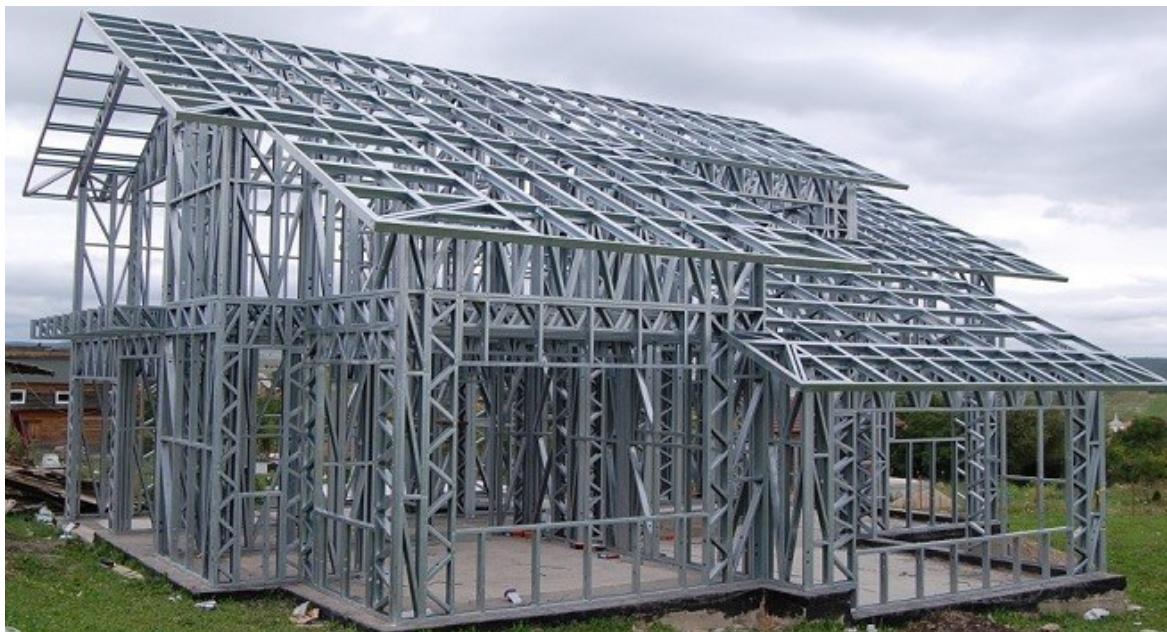
Рис. 6.1. Приклад каркасу ЛСТК
