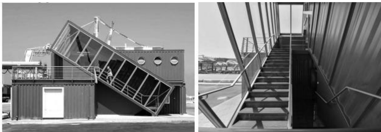
Рис. 1.6 – Офісна будівля з 7 вантажних корабельних контейнерів (контейнер зі сходами розміщений під кутом 30 градусів) в порту Ашдод (в 30 кілометрах від Тель-Авіва); дизайнстудія «Potash Architects» [24].
