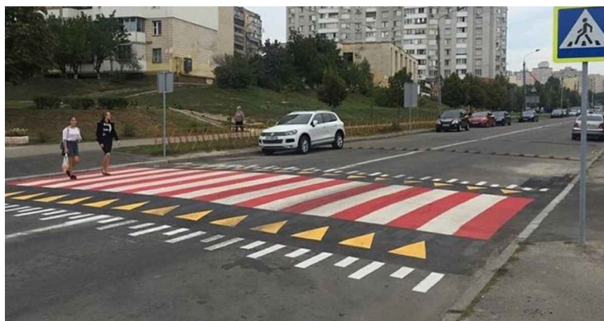
Рис. 3.2. Приклад піднятого пішохідного переходу
