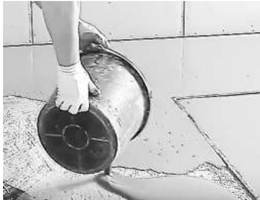
Рис. 12.6. Заливка самовирівнювального розчину
