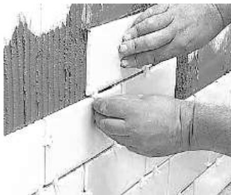
Рис. 12.11. Наклеювання плиток і встановлення хрестиків між плитками
