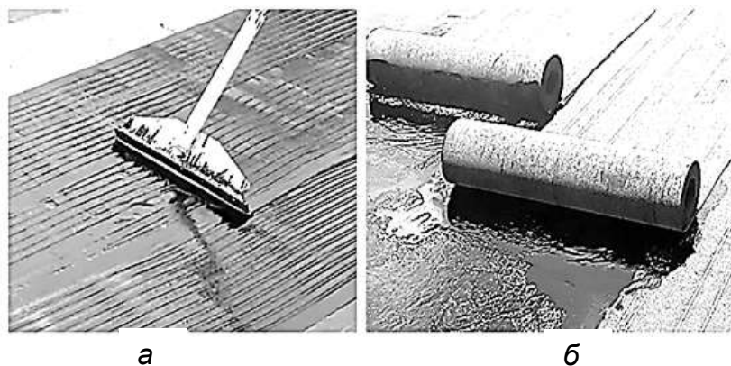
Рис. 12.7. Наклеювання рулонного матеріалу на поверхню:
