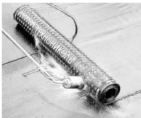
Рис. 12.8. Наклеювання полотен:
