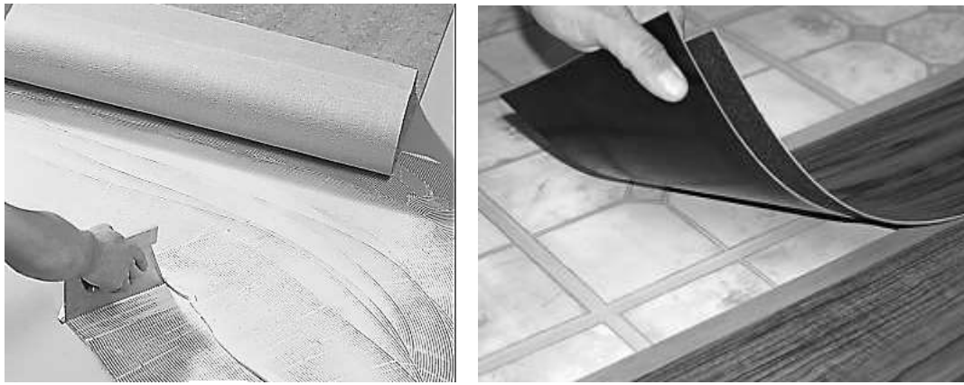
Рис. 12.9. Наклеювання лінолеуму на основу підлоги: а – у вигляді рулону; б – у вигляді гнучкої плитки з самоклеїним шаром
