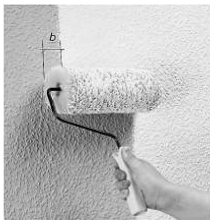
Рис. 12.3. Нанесення фарби валиком
