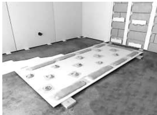
Рис. 12.13. Підготовка листа ГКЛ до наклеювання на стіну
