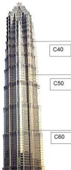
Рис. 5.1. Приклад варіювання міцності бетону на поверхях під час будівництва висотного будинку (450 м) в Шанхаї (КНР)
