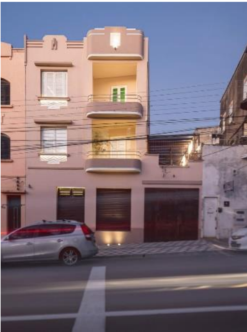
Рис. 2.3.3. Coworking Casa Pedra Фасаd[15]
