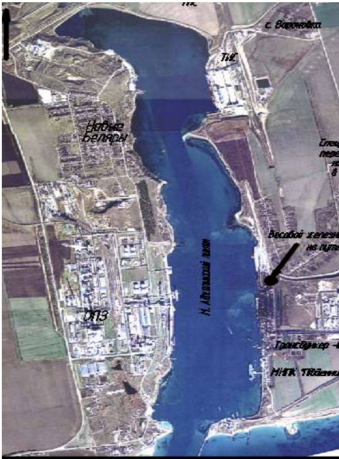
Рис.2.1. Ситуаційний план району розміщення залізничного вагового комплексу на шляхах № 1, 1а Нижнього майданчику ВРР-2 у ДП «МТП «Южний»
