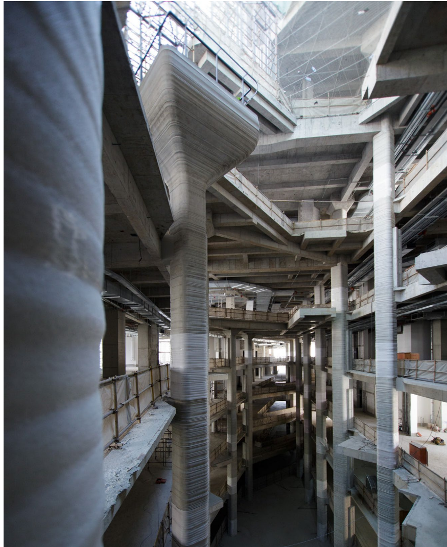
Рис. 2.16. Інтер'єр будівлі під час будівельних робіт. [10]
