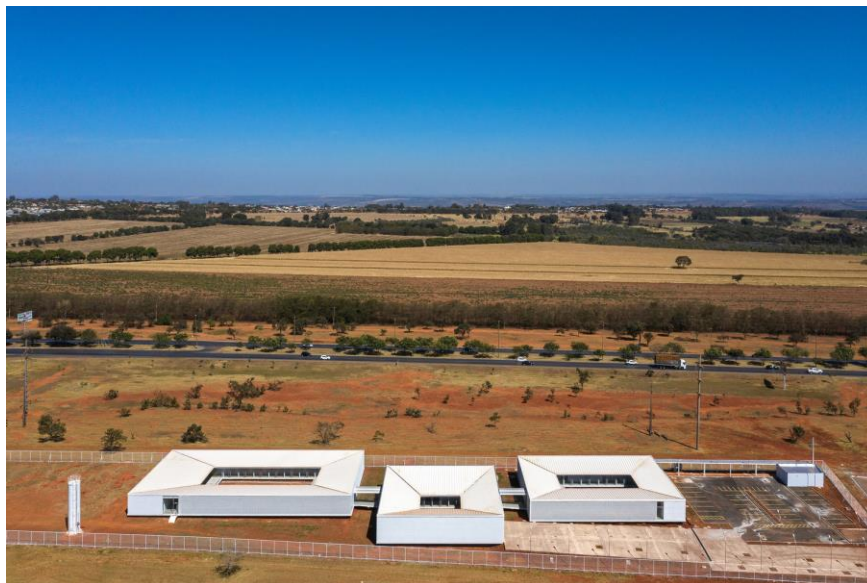
Рис. 2.11. Вигляд будівлі з висоти пташиного польоту
