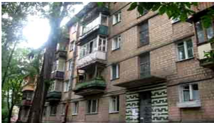
Рис. 2.2. «хрущовки» цегляні п'ятиповерхові (серія 1-438). Конструктивна схема – безкаркасна з поздовжніми несучими стінами серія 1-438 цегляна [16]
