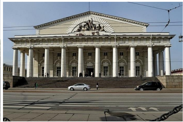
Рис. 45. Будівля біржі на Стрілці Василівського острова, . Петербург. 1805 – 1816 рр Архіт. Тома де Томон. Великий архітектурний масштаб
