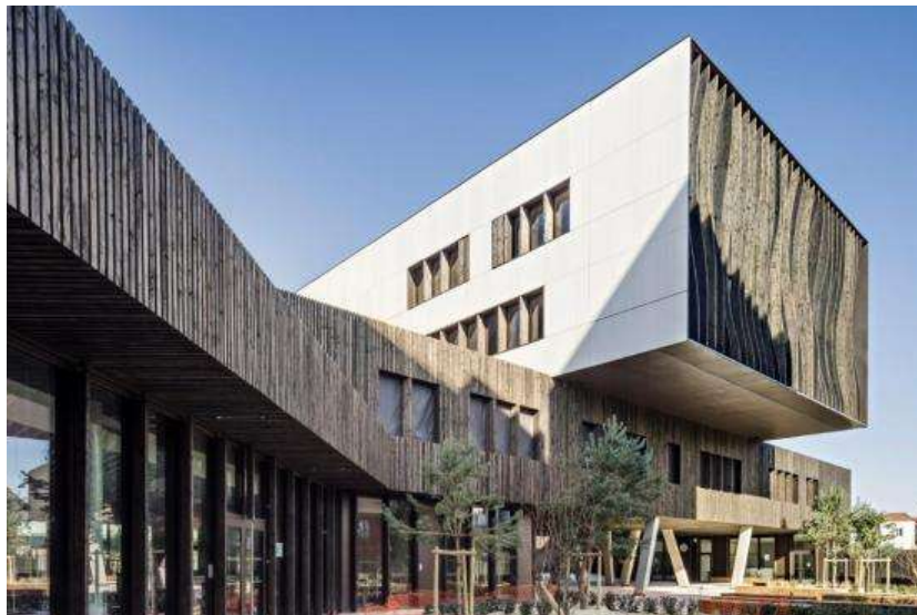
Рис. 2.2.4 Зовнішній вигляд Lycée La Plaine [7]
