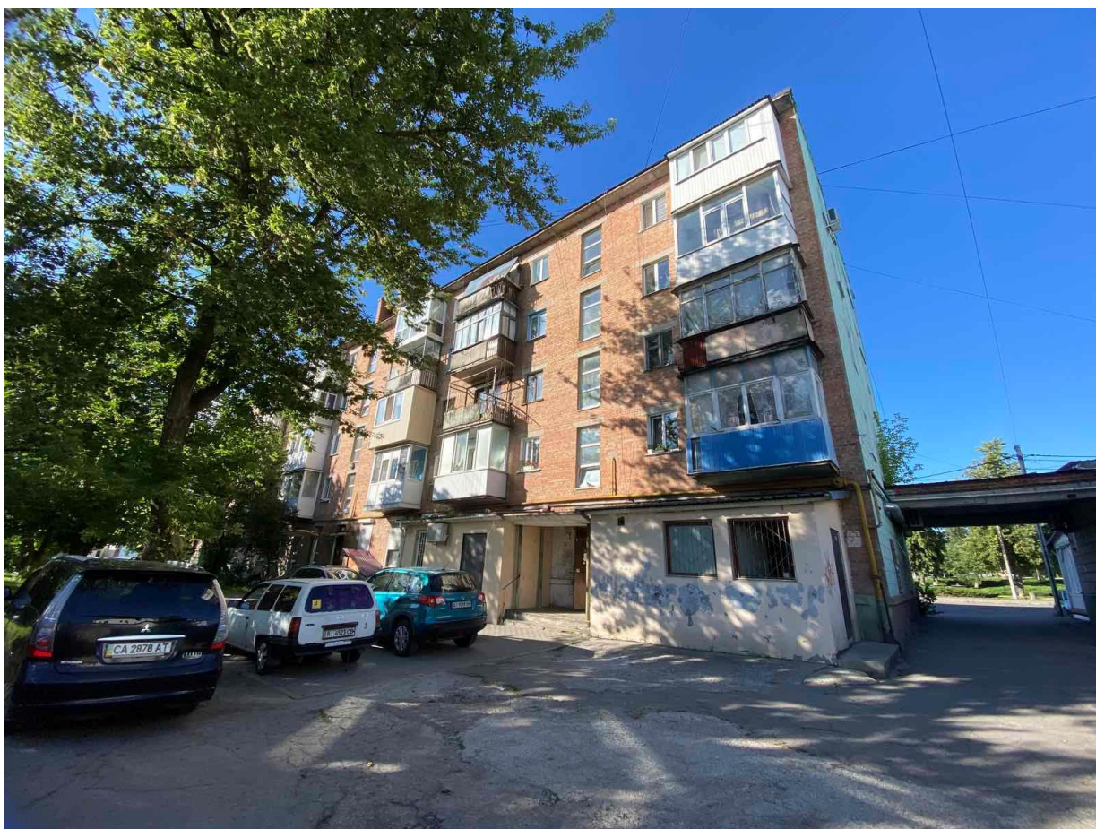
Рис. 2.2 Задня (житлова) частина приміщення з входами до під'їзду
