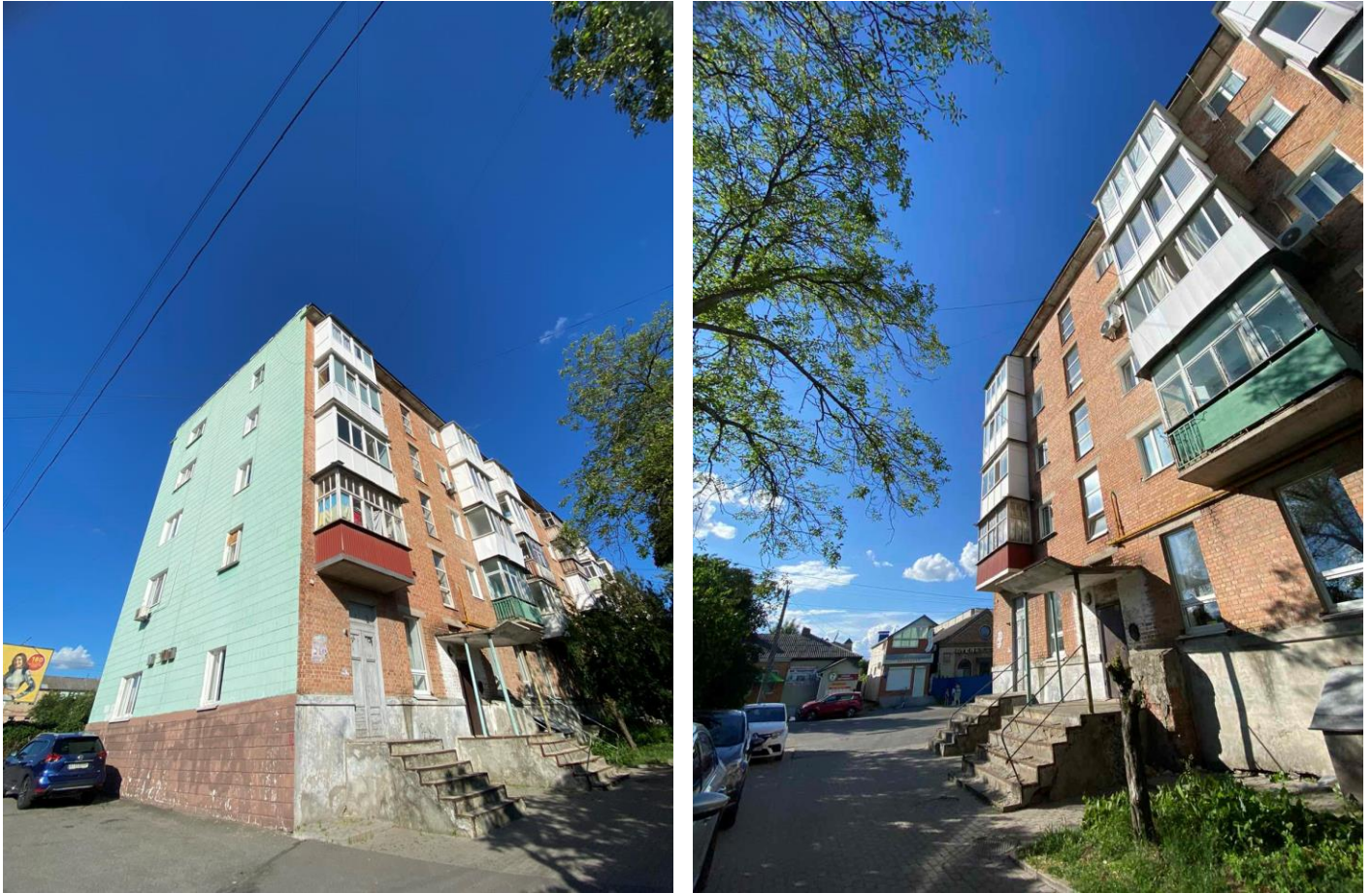
Рис. 2.6, 2.7 Вигляд приміщення збоку, аварійні виходи
