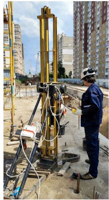
Рисунок 3.1 – Буріння отворів: а – в бетонній конструкції коронкою; б – в ґрунті буром, встановленим в перфоратор; в – в ґрунті шнеками на малих бурових установках
