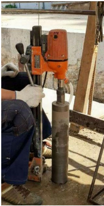
Рисунок 3.1 – Буріння отворів: а – в бетонній конструкції коронкою; б – в ґрунті буром, встановленим в перфоратор; в – в ґрунті шнеками на малих бурових установках
