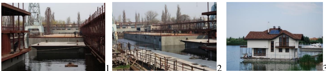
Рис.6.1. Приклади застосування залізобетонних понтонів:
