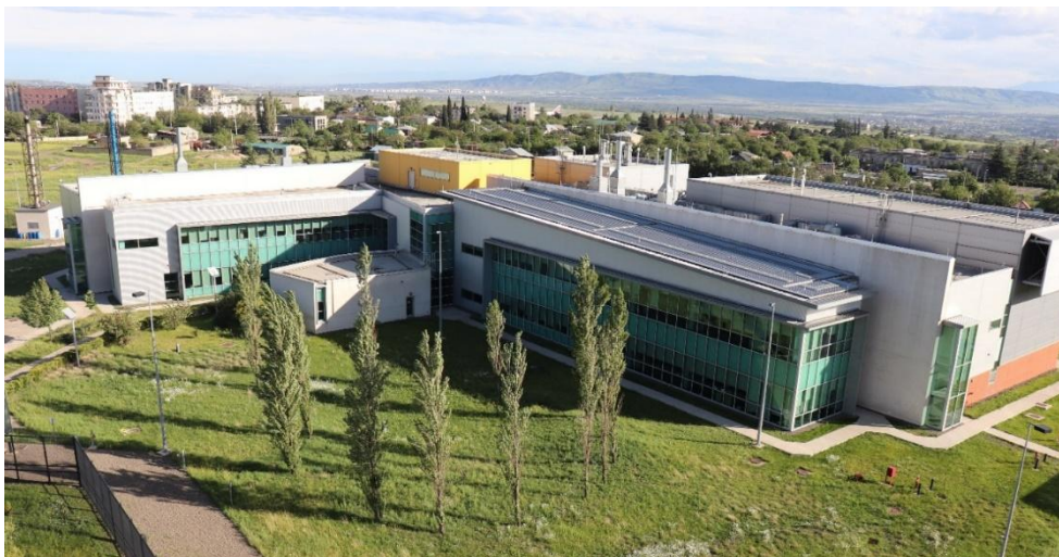
Рис. 1.23. Будівля дослідницького корпусу Richard Lugar Center for Public Health Research.
