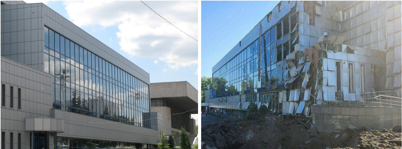
Рис. 1.4.11. Постраждання будівлі спортивного плавання, Дніпро, 1968 р. [52]
