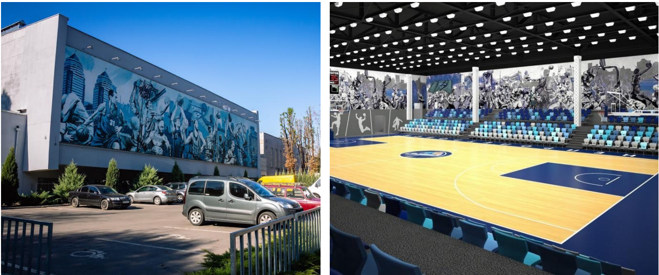
Рис.1.4.13. Баскетбольна зала комплексу «Шинник», Дніпро, 1970-ті рр. [51]
