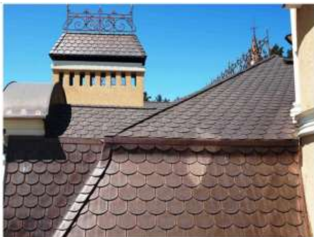
Рис. 165. Покрівля з бітумних плиток і лицьовим шаром мідної фольги
