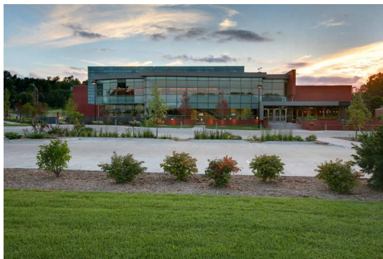
Рис. 2.4.1 Головний фасад будівлі[4]
