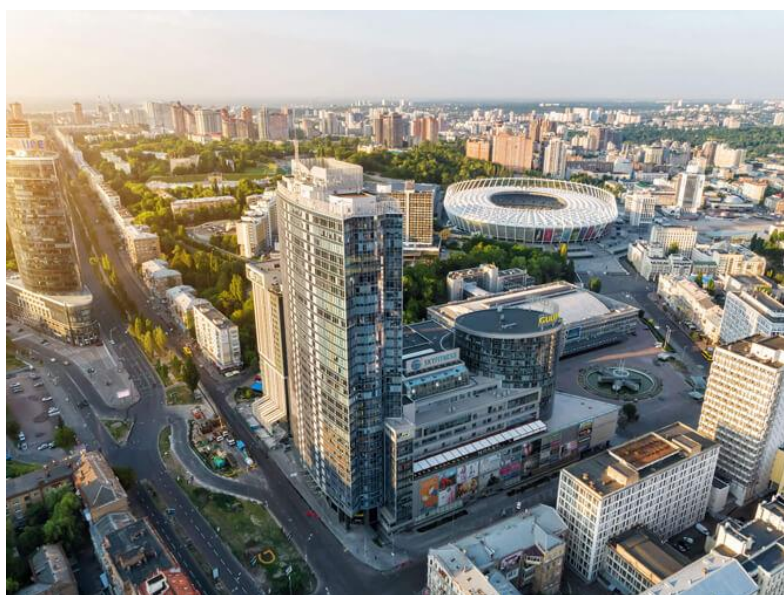
Рис. 2.3.1 Загальний вигляд будівлі [3]
