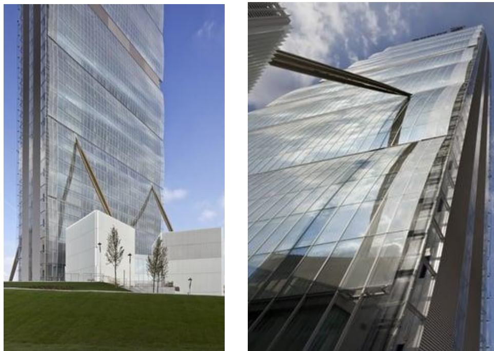
Рис. 6.6, рис. 6.7 Фасади ALLIANZ TOWER [31]
