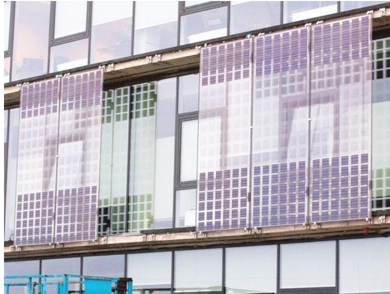
Рис. 6.5. Напівпрозорий сонячний фасад [30]
