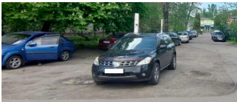
Рис. 3 Ділянка з відсутнім асфальтованим покриттям
