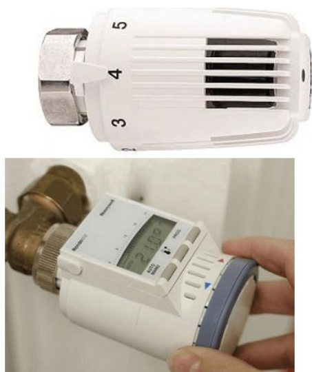
Рис.6.1 Види термостатичних головок для опалювального приладу
