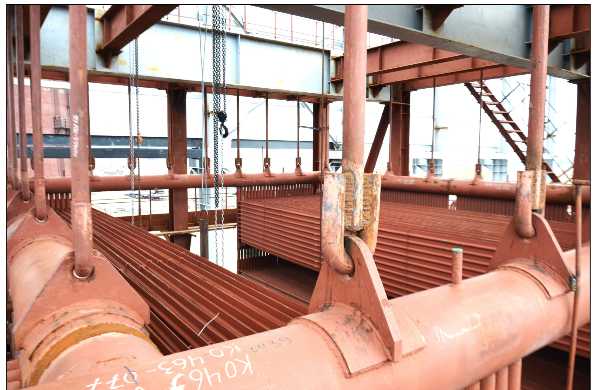
Конвективна частина котла, вид збоку
