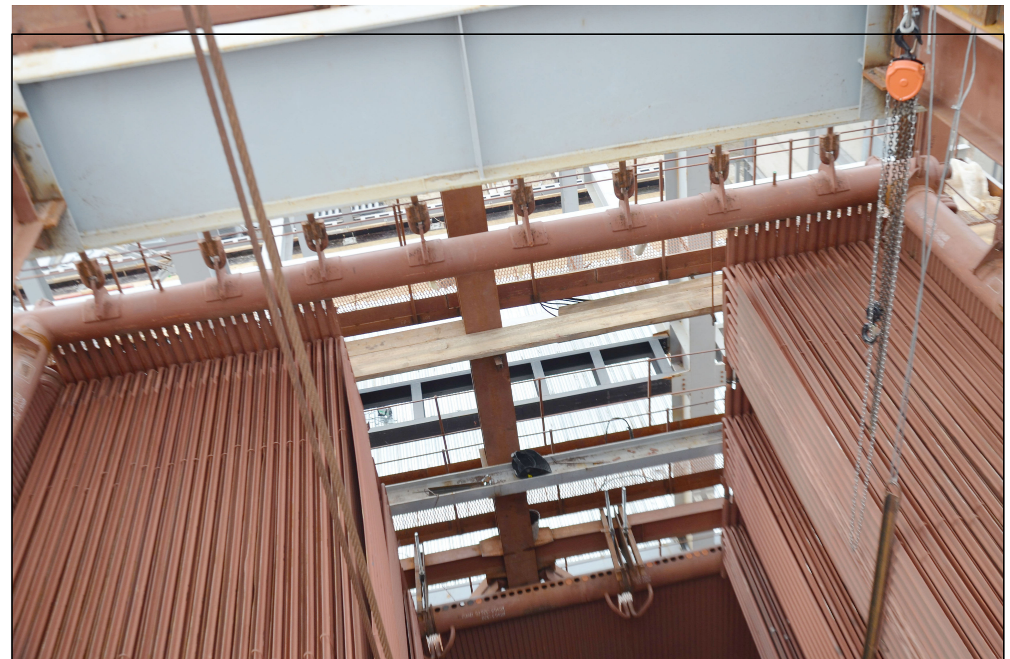
Конвективна частина котла, вид збоку
