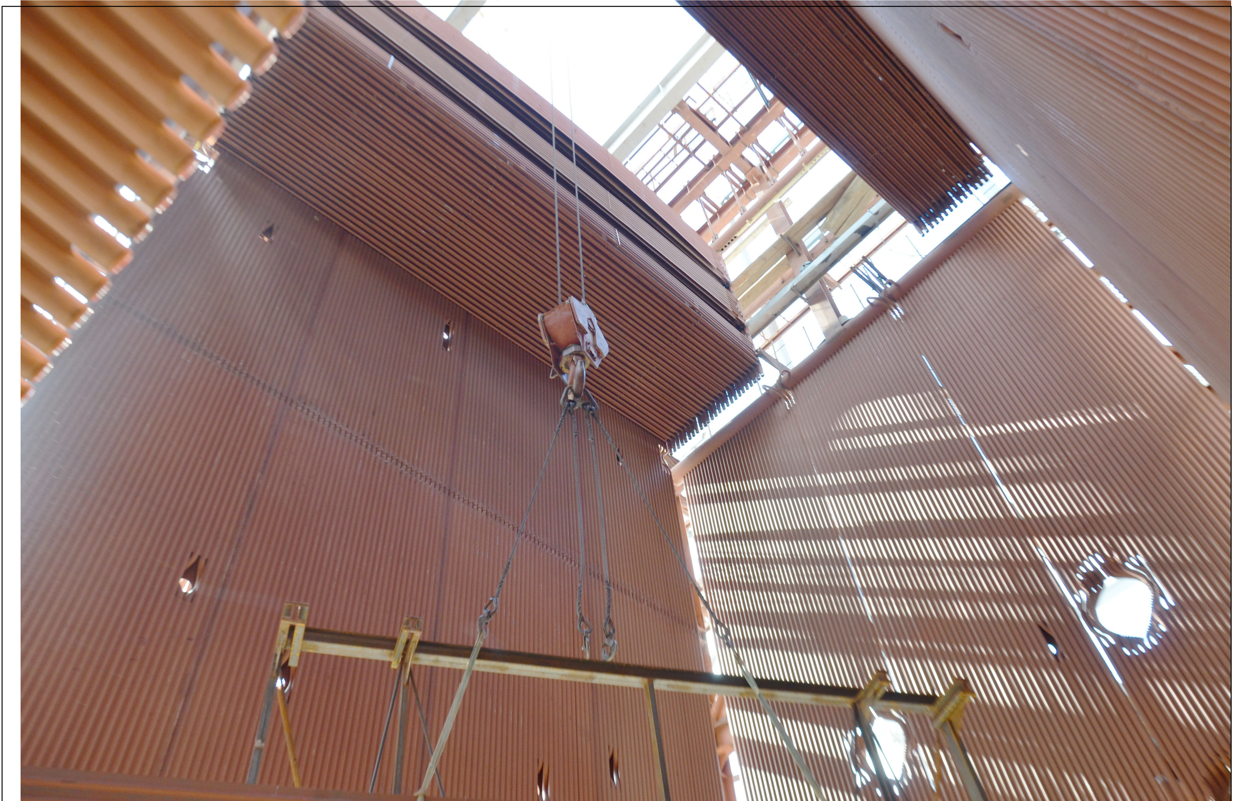
Конвективна частина котла, вид зверху
