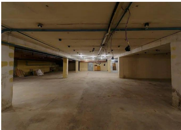
Рис. 2.14. Інтер'єр підвального приміщення КПІ.
