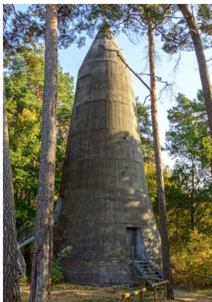
Рис. 1.22. Бетонне бомбосховище у формі ракет у Вюнсдорфі.
