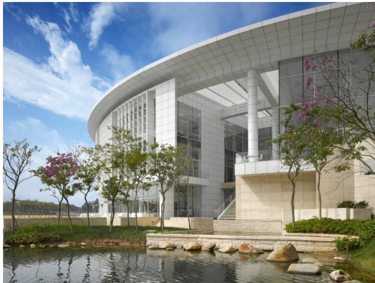
Рис. 2.8.2 Оздоблення фасадів будівлі [18]
