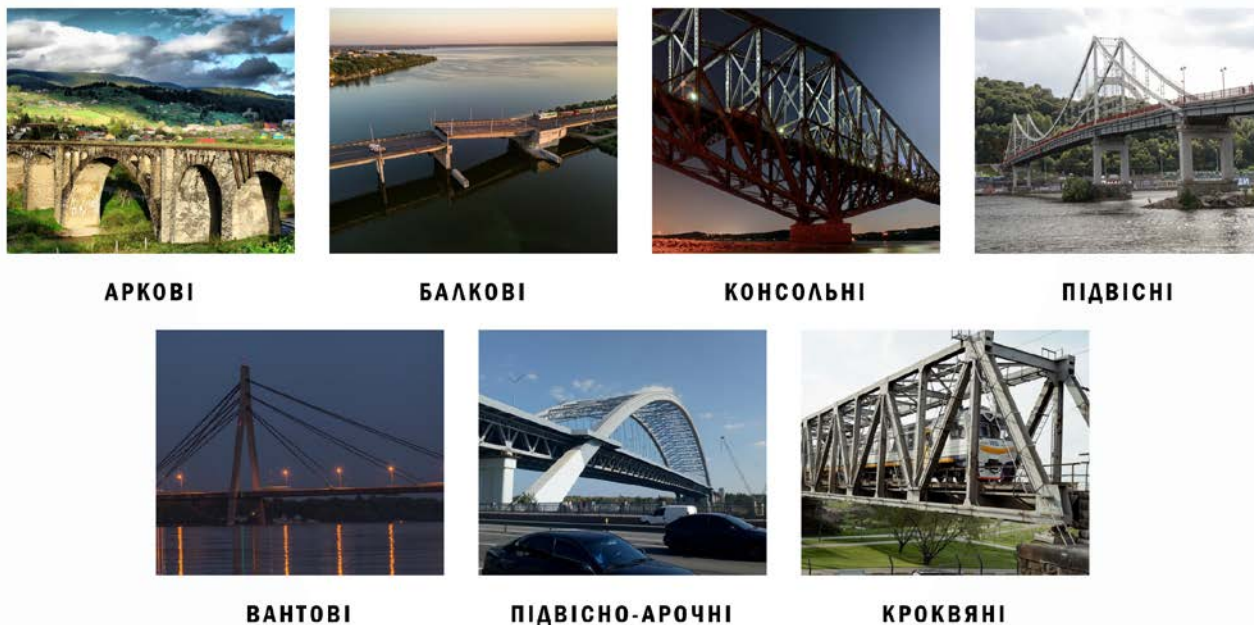
Рис.2.2. Типи мостів за основною несучою конструкцією
