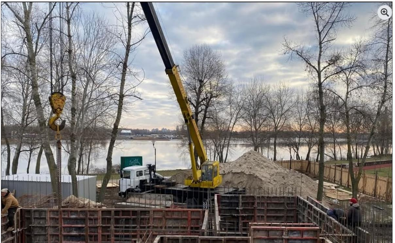
Рисунок 1.1 Будівництво парку «Наталка»
