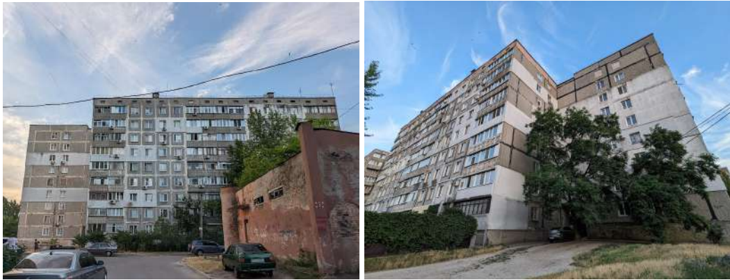
Рис. 3.1.6.2.5. Фотографія панельного будинку, 9 поверхів, розташований за адресою вулиця Лазурна, 4А (південний фасад)
