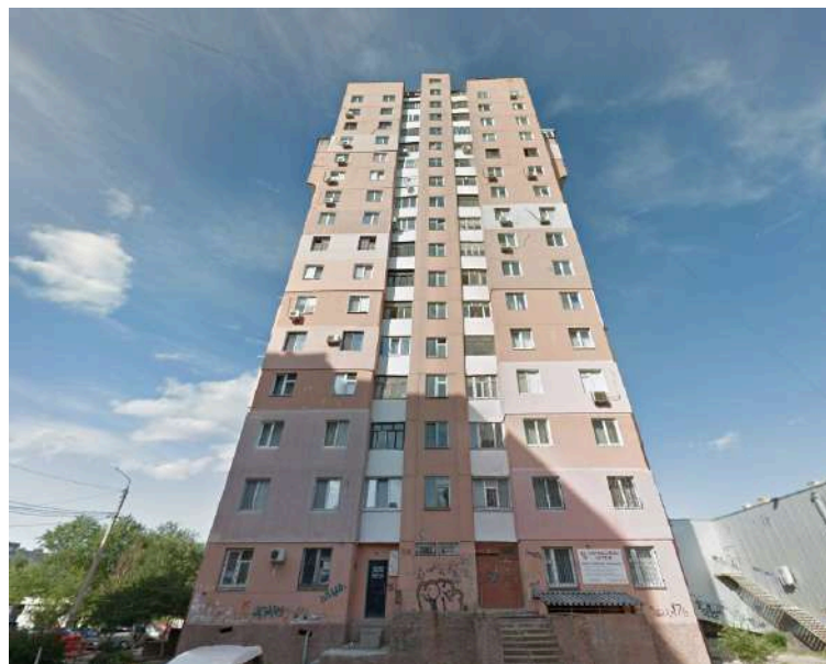
Рис. 3.1.6.2.9. Фотографія панельного будинку, 16 поверхів, розташований за адресою: вулиця Озерна, 17Г
