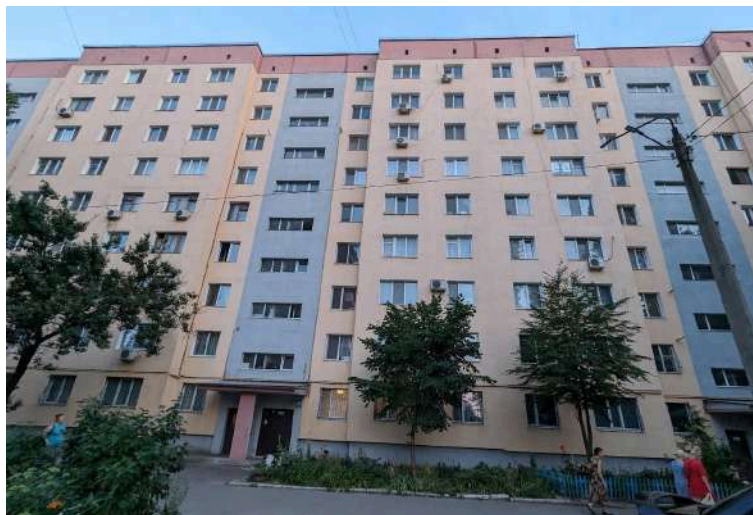
Рис. 3.1.6.2.7. Фотографія панельного будинку, 9 поверхів, розташований за адресою: вулиця Лазурна, 6А
