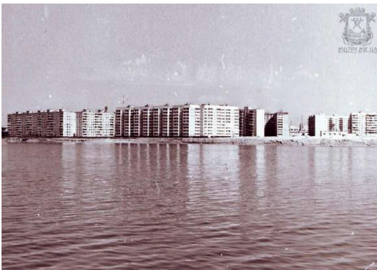
Рис. 3.1.2.1.16. Панорама на мікрорайон Намив в процесі будівництва , 1980-ті роки [60]
