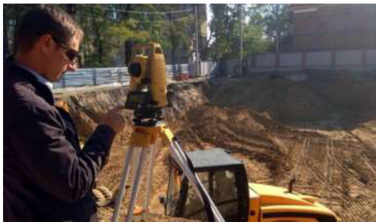
Рис. 20. Геодезичні роботи в котловані
