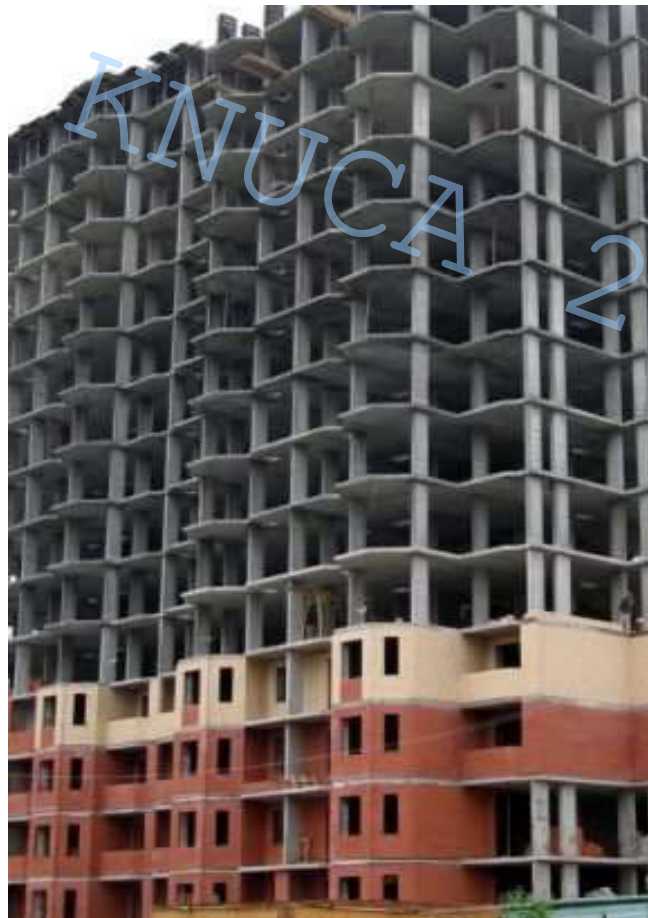
Рис.1. Каркасно-монолітна технологія зведення висотних будівель
