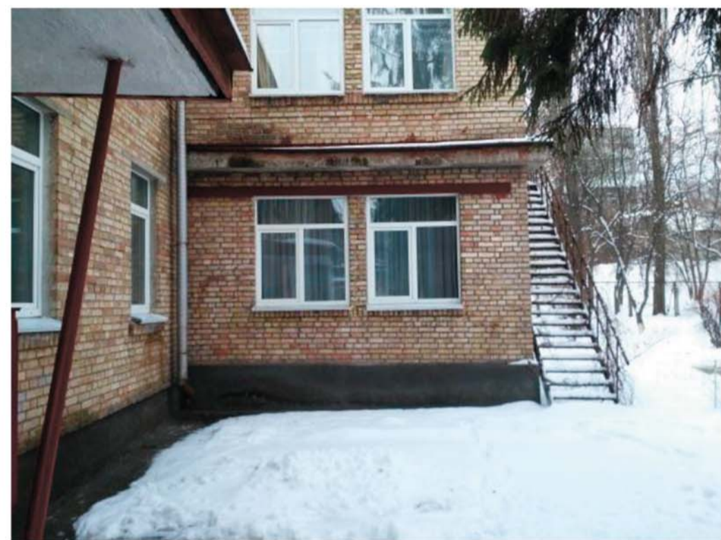
Під час обстеження було виявлено зони промерзання в місцях віконних відкосів. Приклади проблемних зон наведені на рисунках
