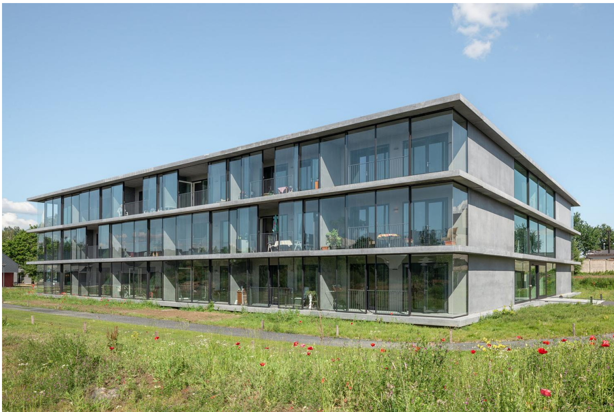
Рис. 2.7. Загальний вигляд будівлі [5]
