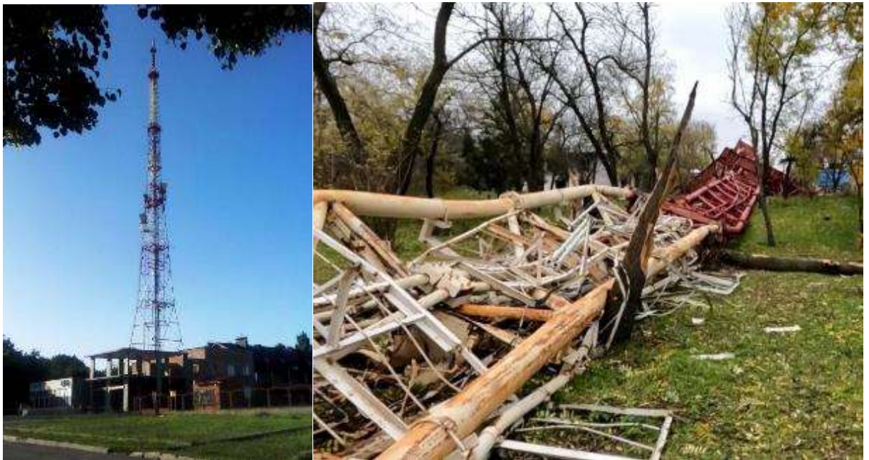
Рис. 3.1.13. Фото телевежі до та після руйнації. [55].
