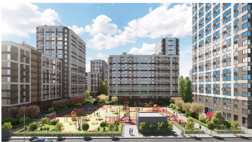
Рис.4.2.2. Загальний вигляд житлового комплексу «Варшавський 2»
