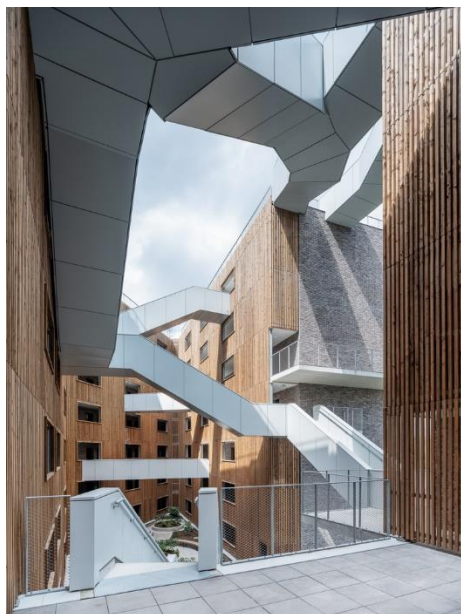
Рис. 1.16 Внутрішній двір гуртожитку
