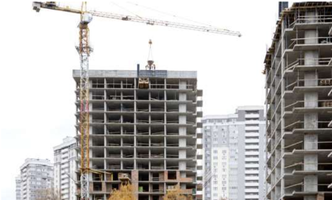
Рис. 1. Зведення монолітного залізобетонного каркасу ЖК «Krona Park II», Київська обл., м. Бровари, 2021 р. [8]
