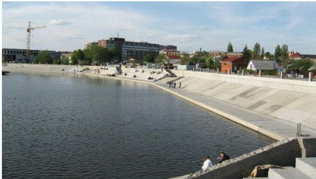
Рис.1.7. – Реконструкція набережної в Вінниці
