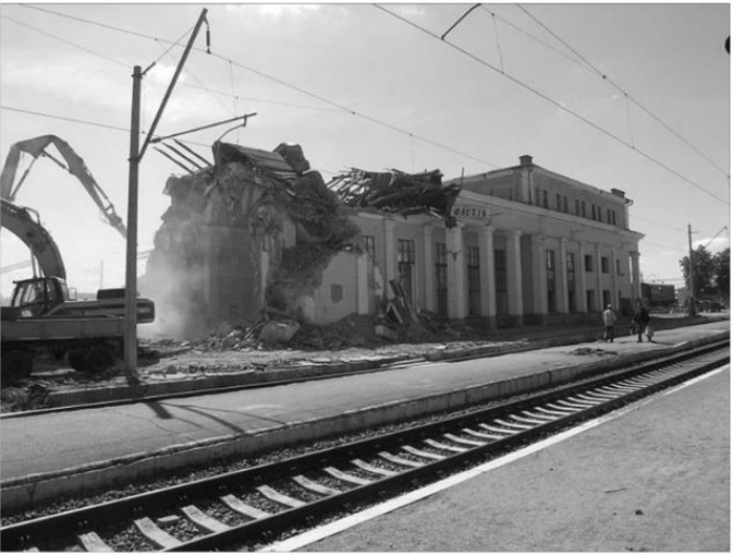
ДЕМОНТАЖ БУДІВЛІ У 2011 РОЦІ
