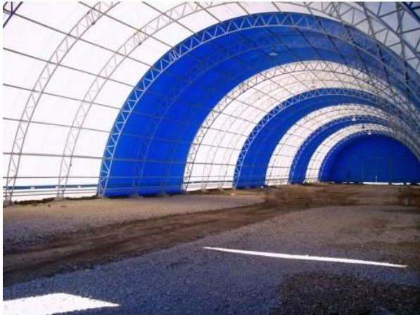
Рисунок 3. Конструкції каркасно-тентових ангарів
