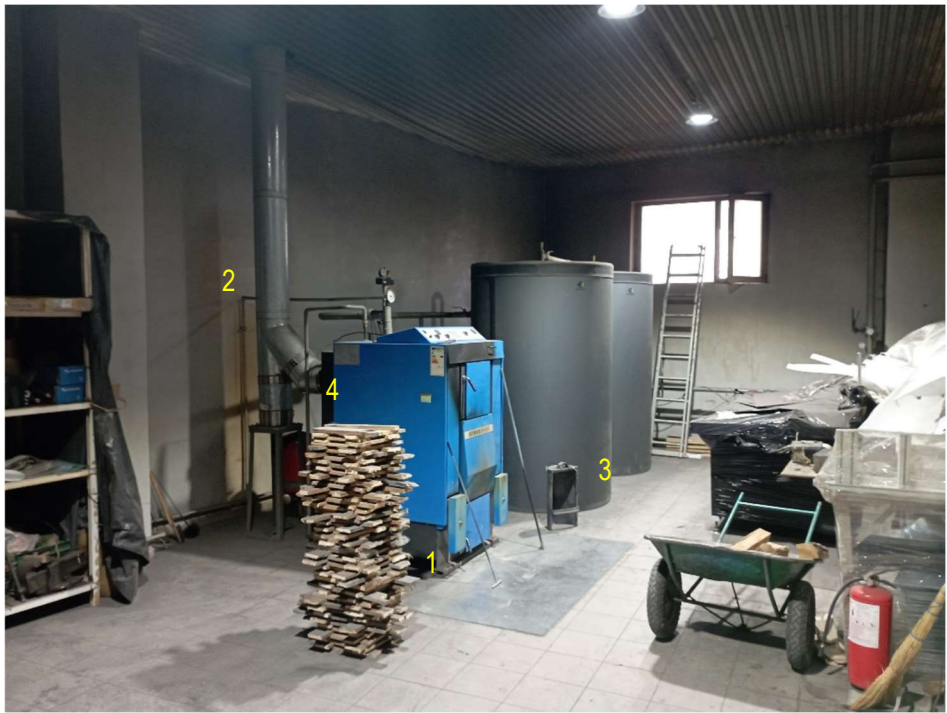
Рис. 3 Схема розташування обладнання у топковій
