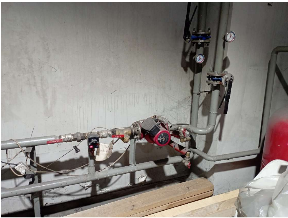
Рис.2. Мережевий насос з обв'язкою (контур споживача)
