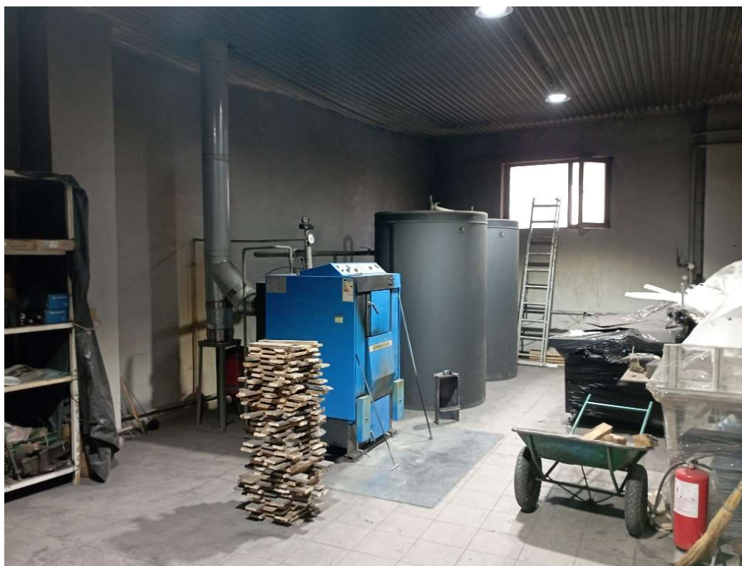
Рис.1. Загальний вигляд існуючої котельні
