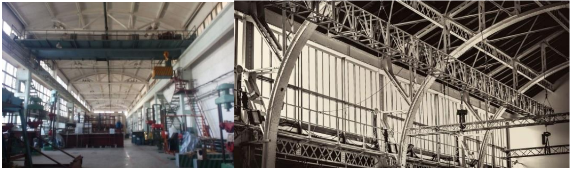
Рис.17. Виробничі зали, нові буд конструкції
