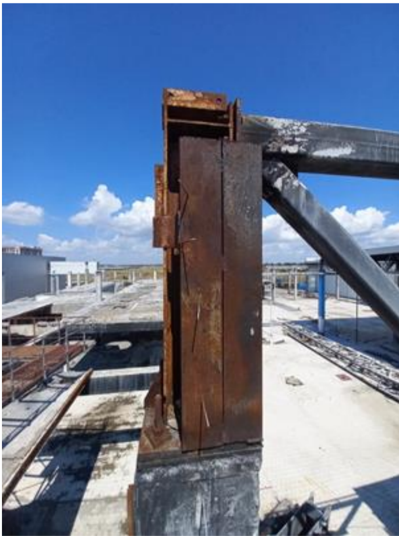
Ослаблені болти кріплення ферм в опорних вузлах. Болти втратили свою міцність
