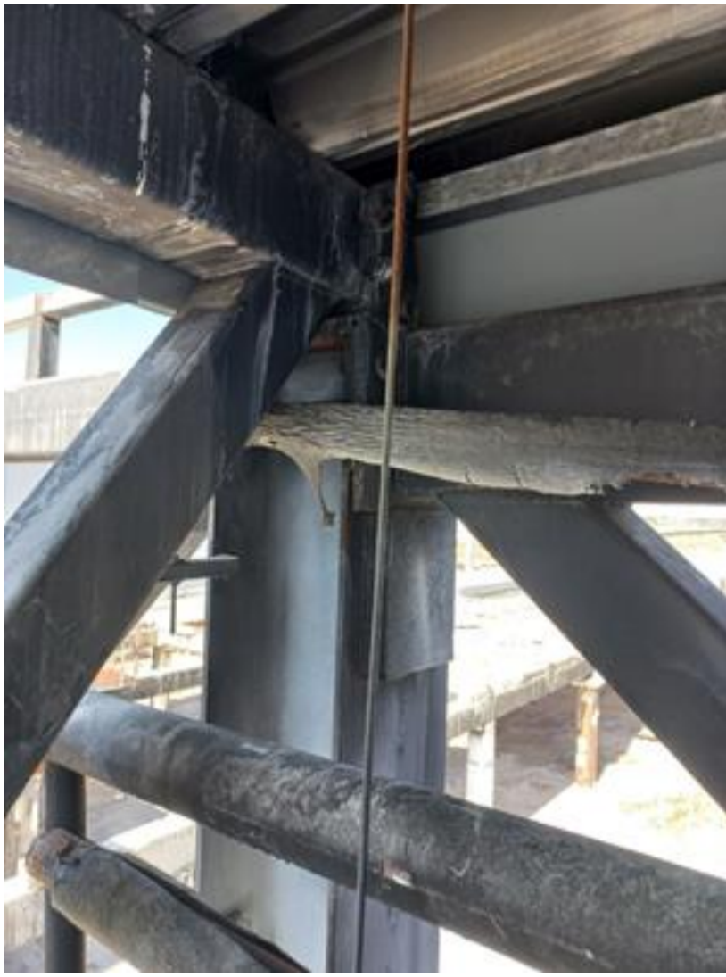
Ослаблені болти кріплення ферм в опорних вузлах. Болти втратили свою міцність
