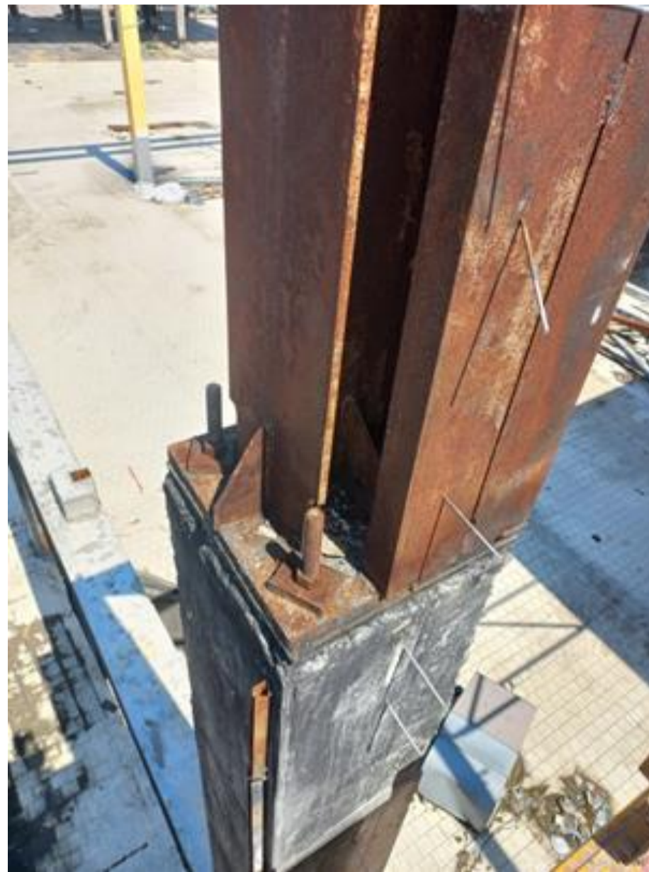
Пошкоджений металевий надколонник під опори ферми. Метал надколонника втратив фізико-хімічну властивість від термічного впливу
