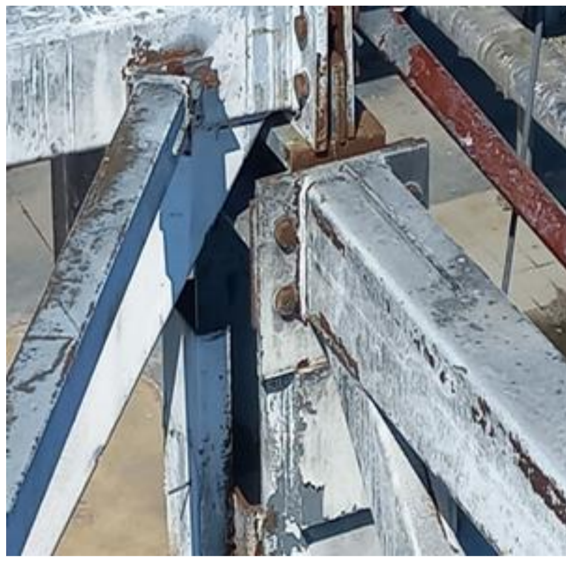
Ослаблені болти кріплення ферм в опорних вузлах. Болти втратили свою міцність
