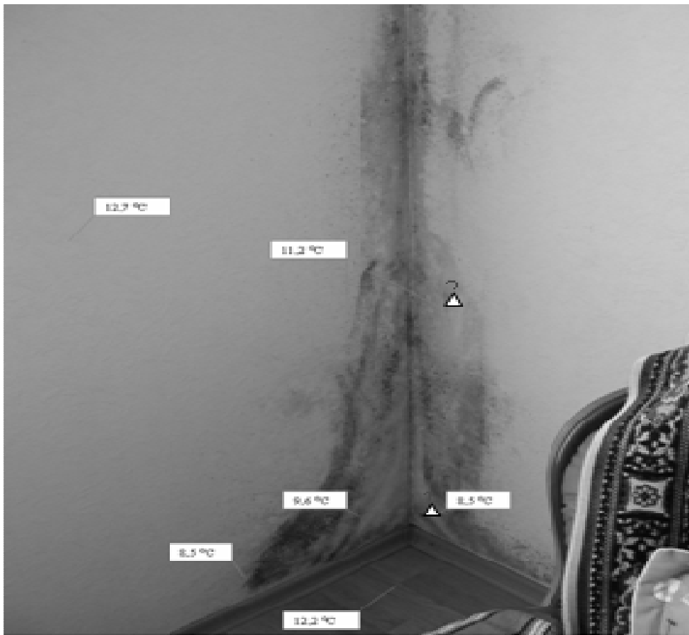
Рис.5 – Фактичний тепловий стан конструкції
