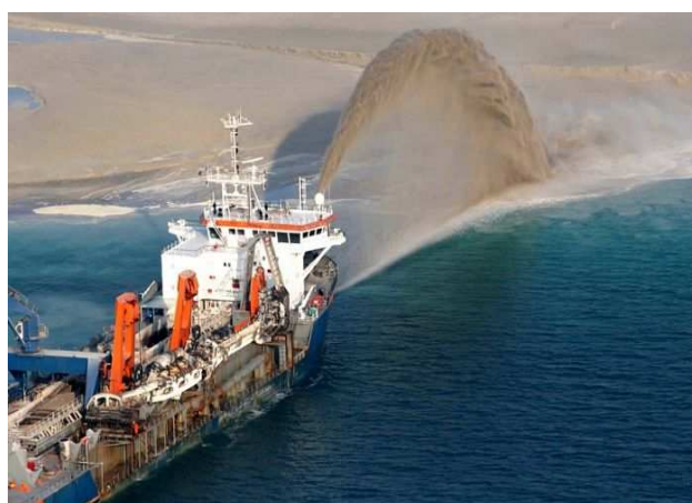
Рис. 6. Намив штучного острова Fig. 6. Alluvium of artificial island
