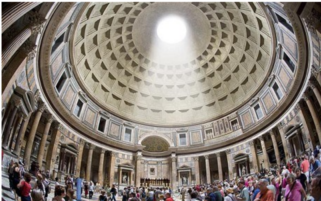
Рис. 15. Бетонний купол Пантеона в Римі
