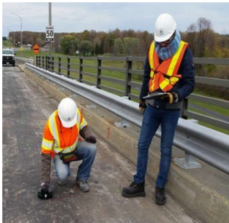
Рис. 20. Моніторинг стану арматури в польових умовах
