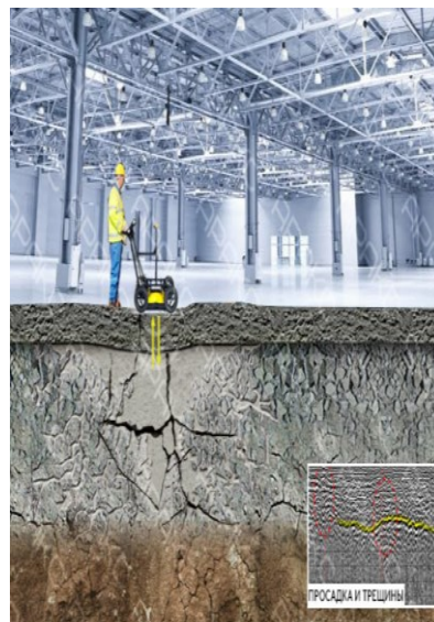
Рис.14. Пошук тріщин і пустот в бетонній плиті підлоги за допомогою георадара
