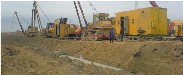
Рисунок 2. Ремонтні роботи нафтопроводу
